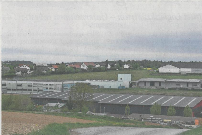
Der Standort Kirchartd von Kaco wird erweitert. Unter anderem soll neben dem Einkaufsmarkt (rechts hinten) ein Verwaltungsgebäude entstehen. Foto: Gabriele Schneider
